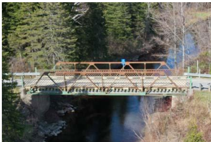
Le pont dit Edmond-Blais a été érigé en 1914 au-dessus de la rivière Daaquam sur la route Edmond-Blais à Saint-Camille-de-Lellis. Il s'agit d'un pont à poutres triangulées en acier de type Pony-Warren.
