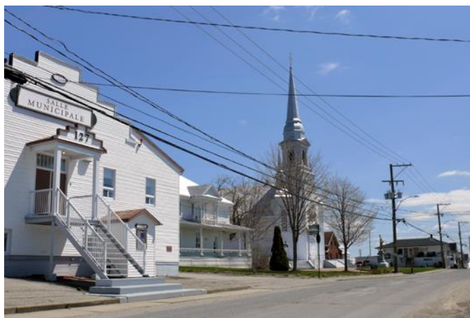
Le noyau villageois de Saint-Magloire avec la salle paroissiale, le presbytère et l'église.
