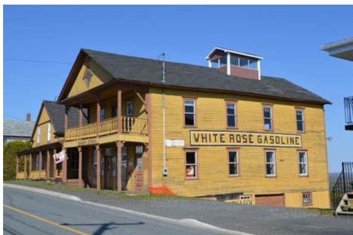
Ancien magasin général. 600-602, rue Principale, Sainte-Rose-de-Watford.
