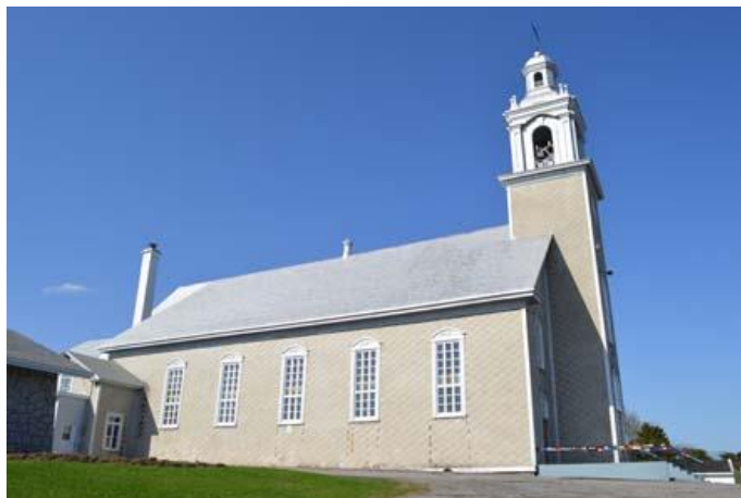
Construite en 1898 par Elzéar Métivier, l'église de Sainte-Rose est revêtue de tuiles d'amiante-ciment alvéolées. 515, rue Principale, Sainte-Rose-de-Watford.
