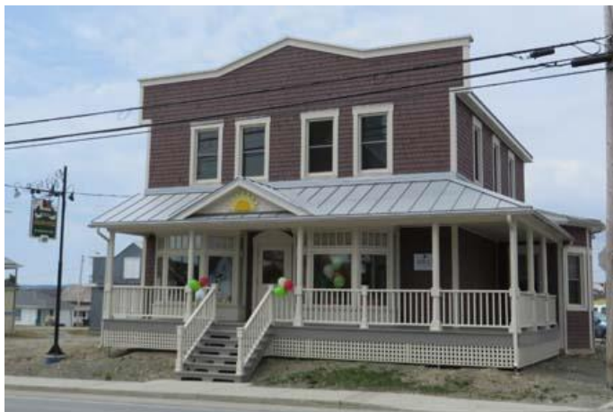
Magasin général Henri-Louis-Poulin (immeuble patrimonial cité). 113-115, rue Principale, Sainte-Camille-de-Lellis.
