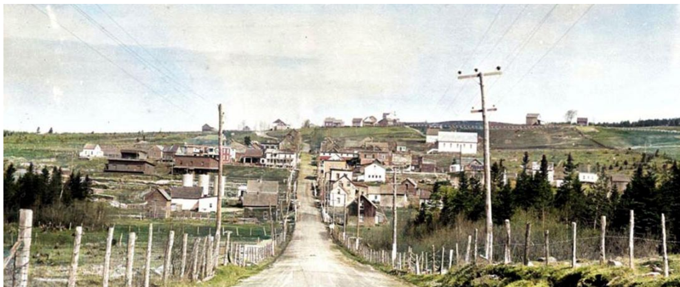
Vue sur le secteur de Sainte-Germaine-Station, localisé de part et d'autre de la route 277. Source : Facebook. « Tu sais que tu viens de Lac-Etchemin quand tu te souviens de... » [en ligne]
