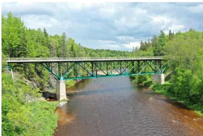
Le pont dit Morisset est une structure à poutres triangulées en acier à tablier supérieur de type Baltimore (Petit) construite en 1928-1929 sur la route 275 au-dessus de la rivière Famine entre Saint-Prospère et Saint-Benjamin.
