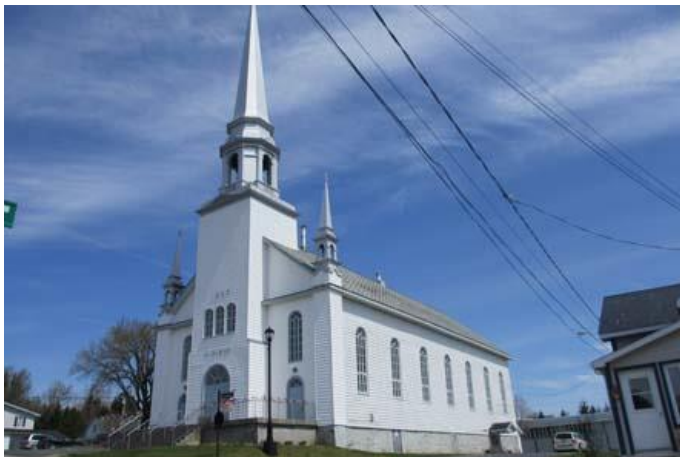
L'église de Sainte-Sabine est construite en 1907 selon les plans de l'architecte David Ouellet. 88-A, rue Principale, Sainte-Sabine.
