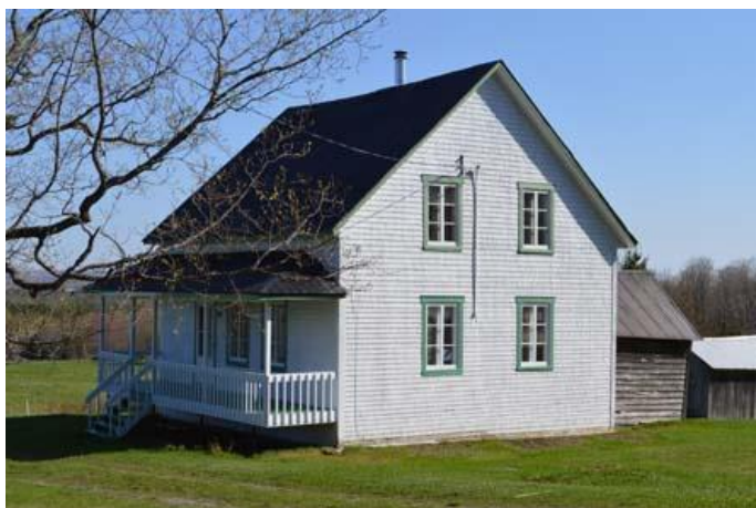
Maison de colonisation dérivée du modèle de la maison vernaculaire américaine d'un étage et demi. Entirement revêtue de bardeau de bois, elle possède une galerie ouverte et des chambranles aux fenêtres. 220, 5 e Rang, Sainte-Rose-de-Watford.
