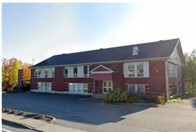
École primaire des années 1950 à Sainte-Germaine-Station qui a été transformée en poste de police pour la Sûreté du Québec. Lac-Étchemin. Source : Google Street View
