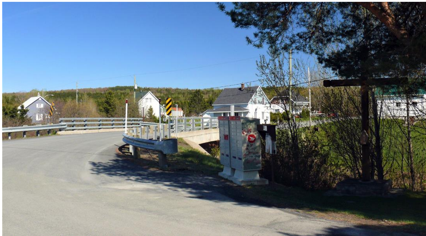
Vue sur le hameau de Sainte-Rose-Station avec le pont qui traverse la rivière à la Raquette alors qu'une croix de chemin marque l'entrée du pont.
